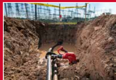
Otwarta konstrukcja szczęk ułatwia podejście do przewodu
